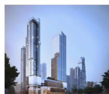
建筑远距离位移检测
