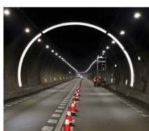
隧道位移测量
